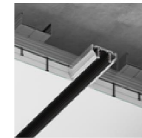
Монтаж в два слоя гипсокартона
